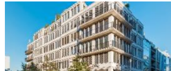
3 Wohn- und Geschäftshaus Jägerstraße 34/35
