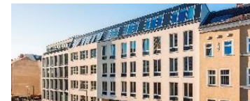
4 Geschäftshaus Bernburger Straße 30/31
