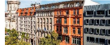
2 Wohn- und Geschäftshaus Jägerstraße 54/55
